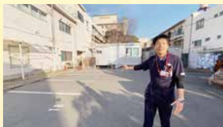
病院の裏手にあるコロナユニット。救急車からの搬入もスムーズな動線を整えています。
